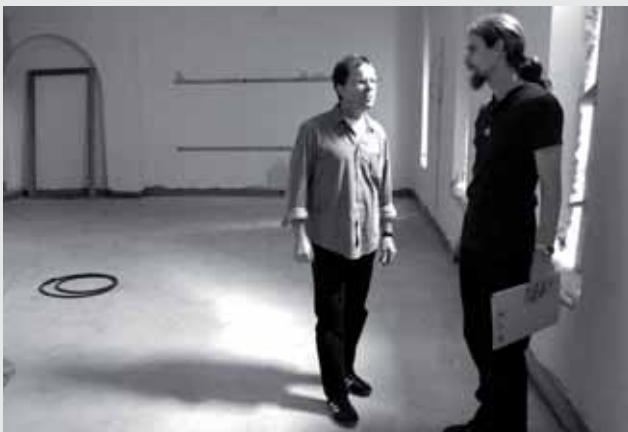
Künstler Mario Schoßer (l.) und einer seiner Mitarbeiter prüfen für die neuen Glasfenster die Lichtverhältnisse in der zukünftigen Kapelle.
